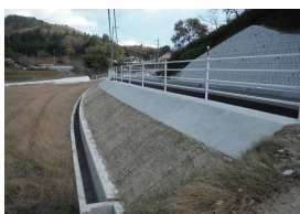
道路改良工事
