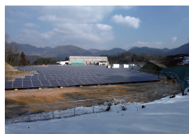
太陽光発電所建設工事
