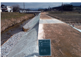
河川改良工事
