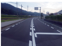
一般国道261号舗装補修工事
