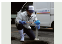
浄化槽維持管理 浄化槽の水の状態を検査し ています。
