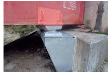
橋梁耐震補強工事
