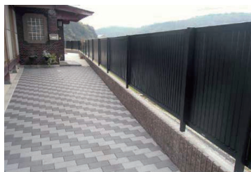
インターロッキング・フェンス工事
