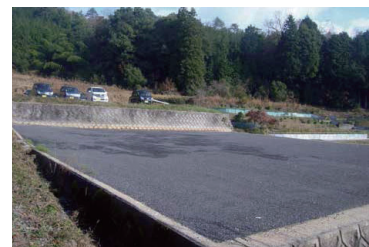
宅地造成・舗装工事
