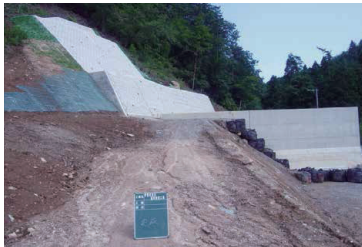
伊勢防谷砂防工事
