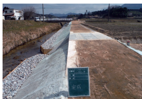
河川改良工事
