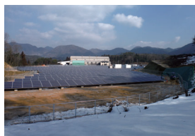
太陽光発電所建設工事
