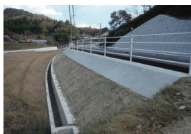
道路改良工事
